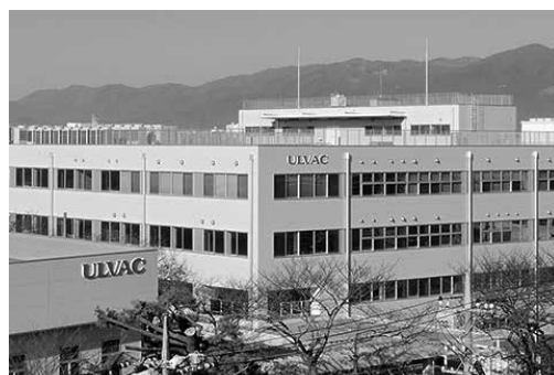
本社外観(右奥：本社棟、左手前：ケミカル本部茅ヶ崎工場)
