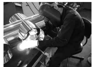
配管の溶接の様子
