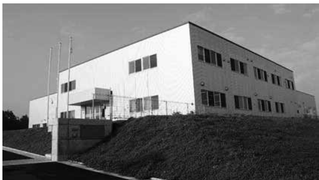
三愛プラント工業 かずさクリーンテック事業所外観
